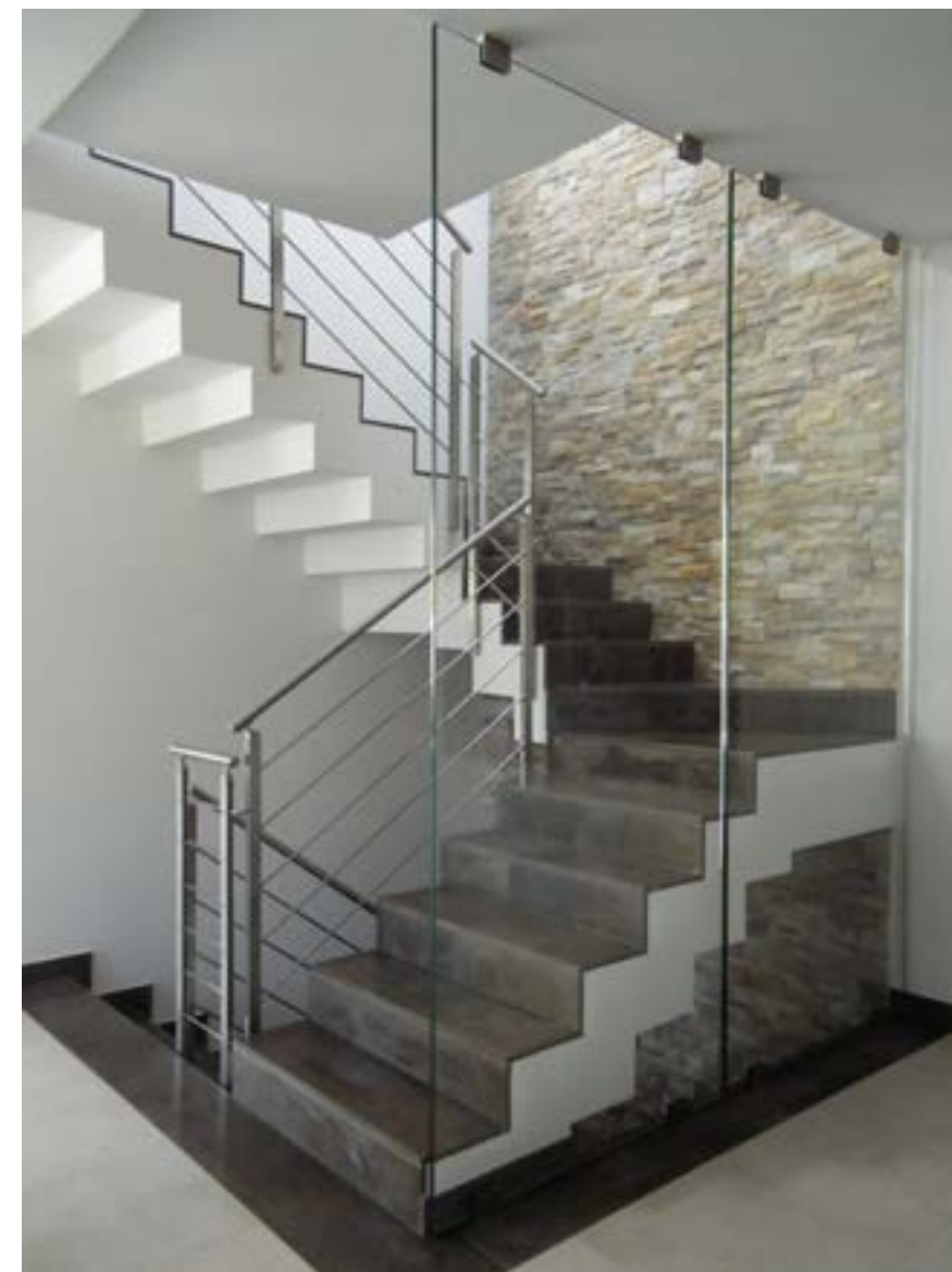
L2 INOX RINGHIERA IN ACCIAIO INOX SATINATO.
