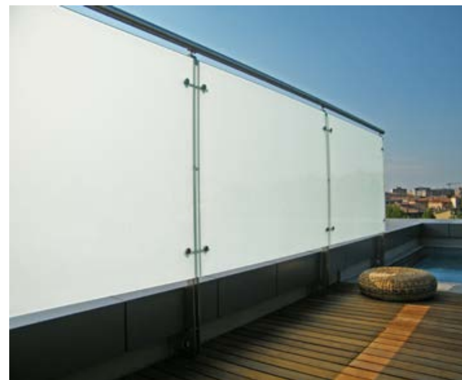
R-GLASS RINGHIERA IN VETRO E ACCIAIO INOX SATINATO AISI 304/316.
