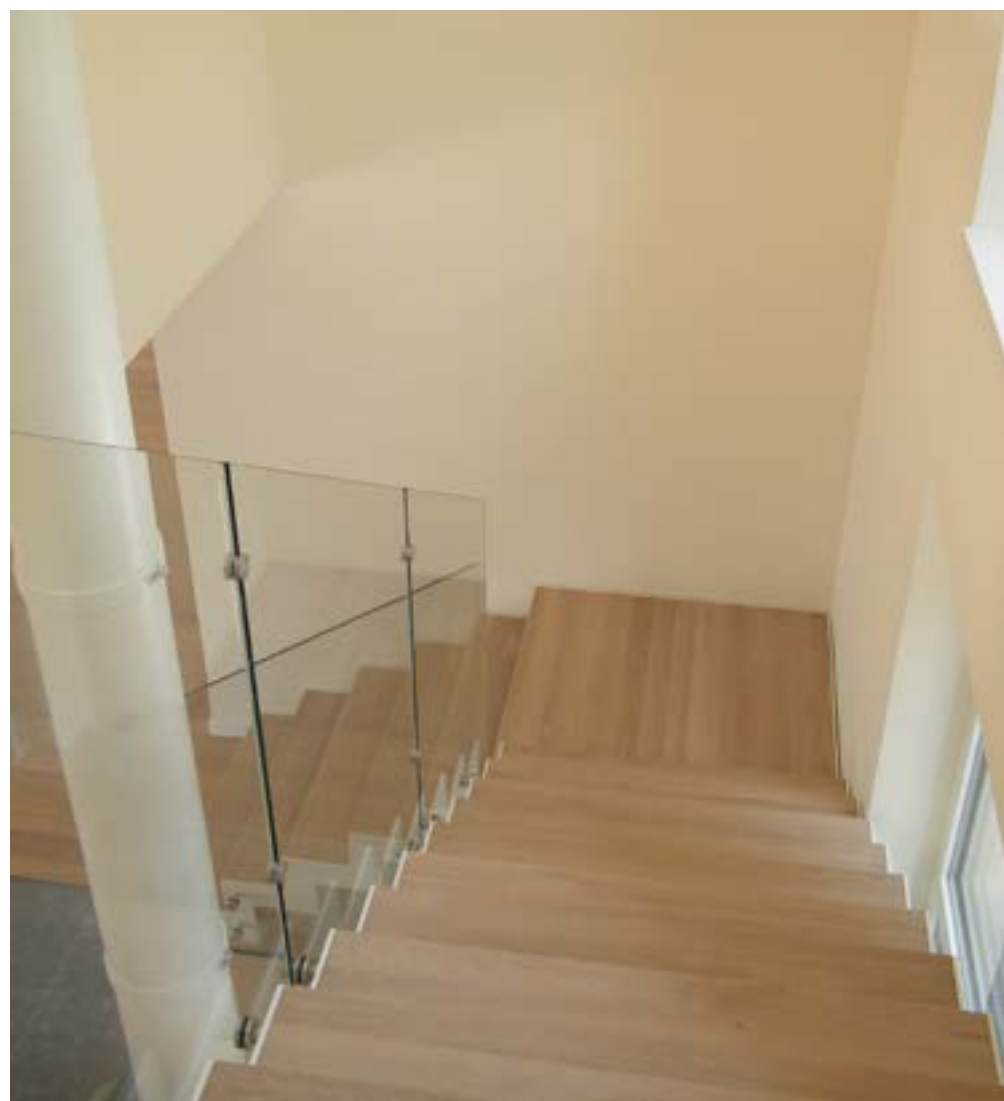
PURE GLASS RINGHIERA IN VETRO PORTANTE CON FISSAGGIO A TASCA ANNEGATA NEL PAVIMENTO.
