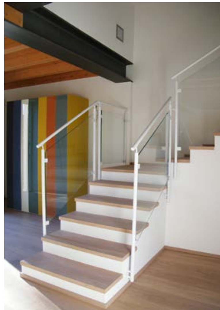
T1 + GLASS RINGHIERA IN ACCIAIO TUBOLARE VER- NICIATO. VETRO + PINZE.
