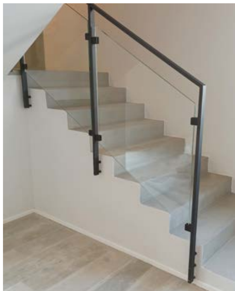
ARK + GLASS RINGHIERA IN ACCIAIO TUBOLARE CON VETRO
