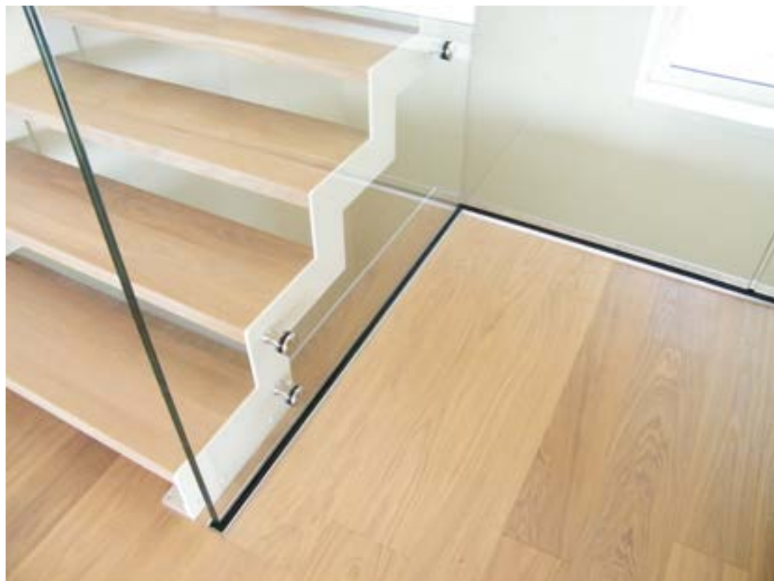
PURE GLASS RINGHIERA IN VETRO PORTANTE CON FISSAGGIO A TASCA ANNEGATA NEL PAVIMENTO.
